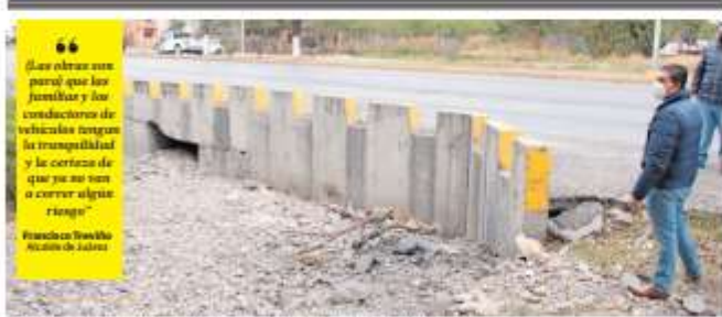
El alcalde de Juárez supervisa la obra durante sesión realizada en obra de drenaje pluvial.
